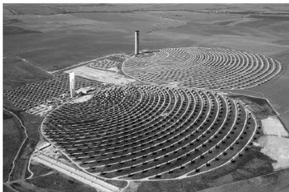
PS10 i PS20 – Sunčeve elektrane sa solarnim tornjem, Sevilla; Pinst = 11 MW i 20 MW
